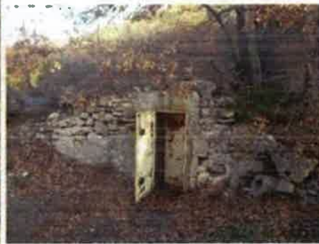
Photographie extérieure de l'entrée de la galerie
