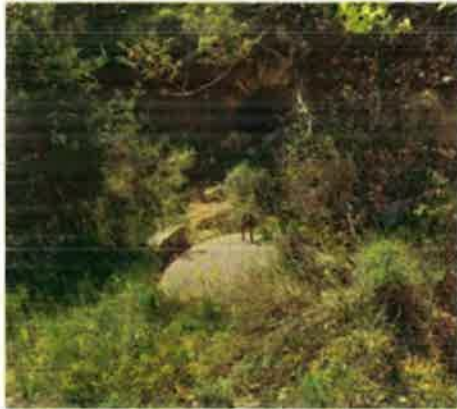
Photographie extérieure de l'entrée de la cavité souterraine (sous le bloc béton)
