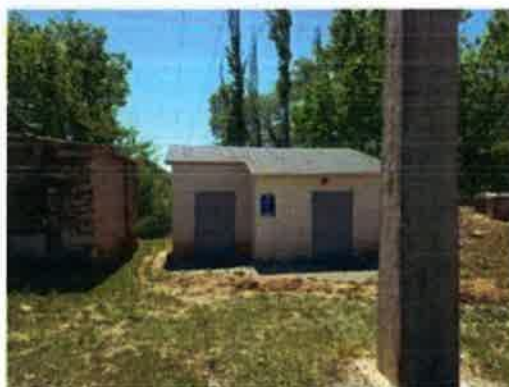
Photographie extérieure de la station de pompage du Beveron
