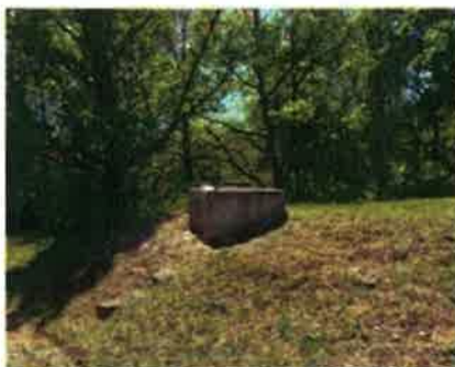
Photographie extérieure de la bache de stockage de 100 m 3
